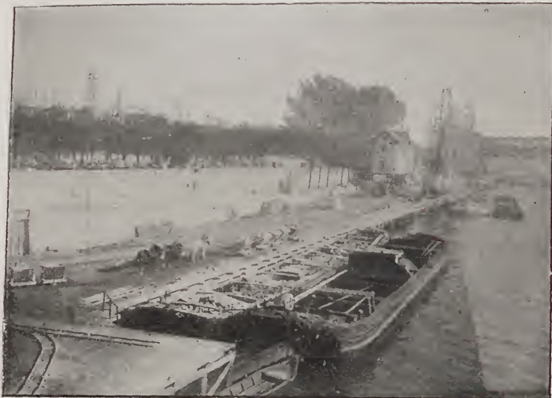
DÉVIATION DES LIGNES DE TRAMWAYS. — Le bas-quai de la Conférence, en aval du pont Alexandre.
